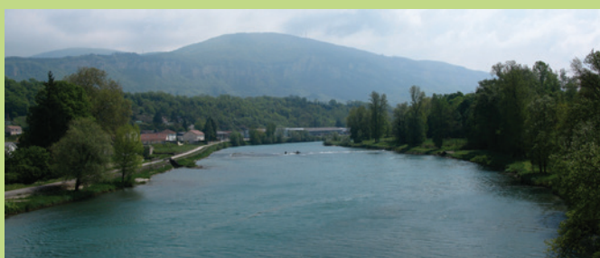
Vue dégagée depuis les franchissements du Rhône
